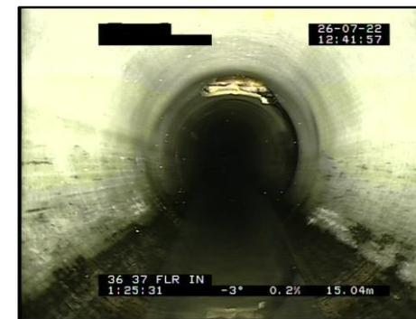
Abbildung 5 Kanal nach Einbau des Schlauchliners.
