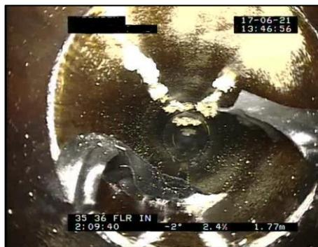
Abbildung 4 Kanal mit einragenden Dichtungen und Fett vor Einbau des Schlauchliners.
