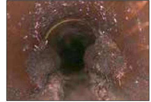
Abbildung 3 Wurzeleinwuchs im Hauptkanal
