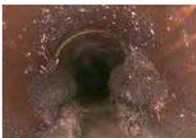
Wurzeleinwuchs im Anschlusskanal
