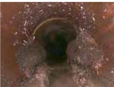
Anschlusskanal mit Wurzeleinwuchs vor Einbau des Schlauchliners
